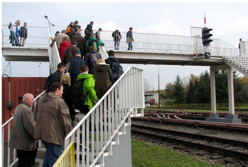
Z kładki jest najlepszy widok na stację postojową Kabaty warszawskiego Metra
